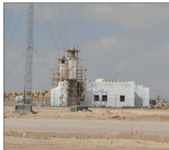
جانب من أعمال ترميم مسجد القرية
