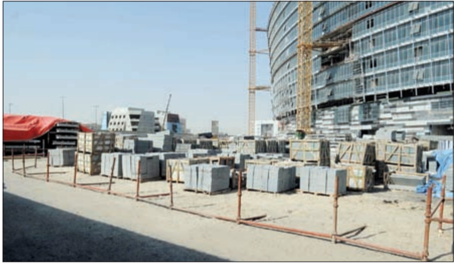
جانب من الإنشاءات بالمبنى
