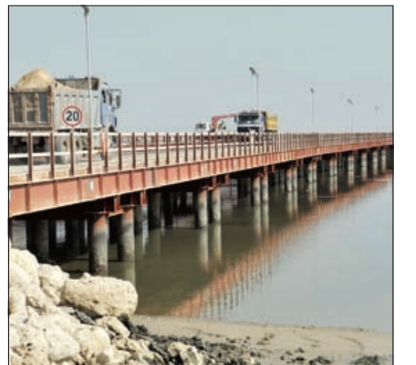
الجسر المؤقت المجهز لعبور الأليات الخاصة بالعمل في المشروع
