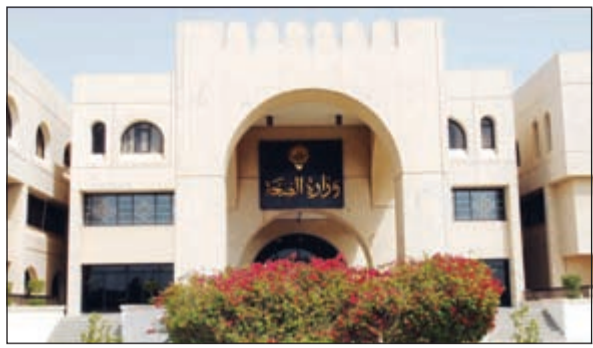
مبنى وزارة الصحة
