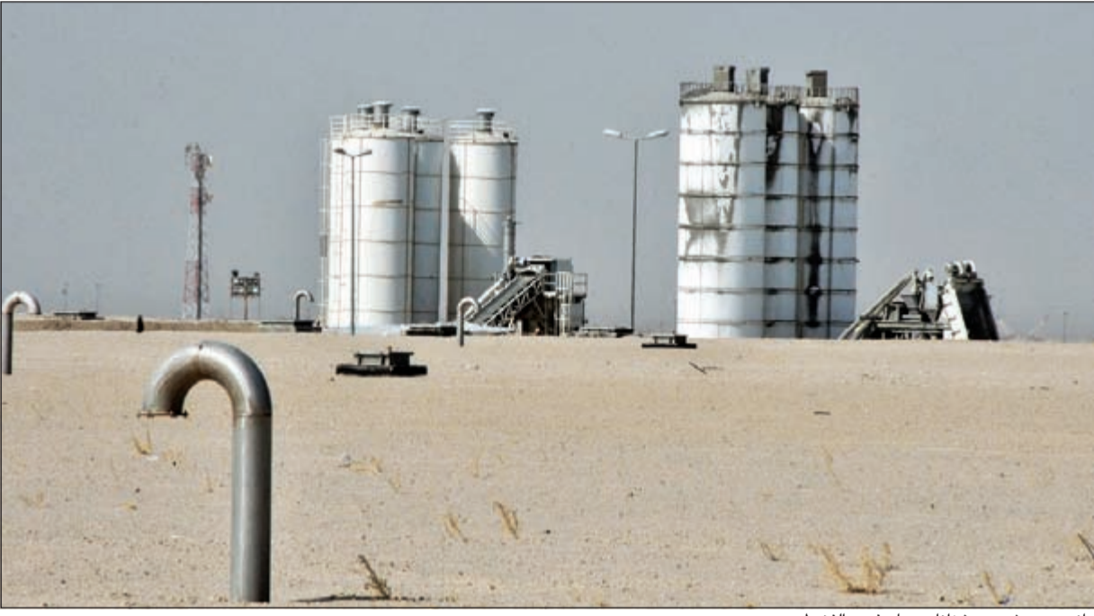
جانب من مشروع خزانات مياه غرب الفينيطيس
