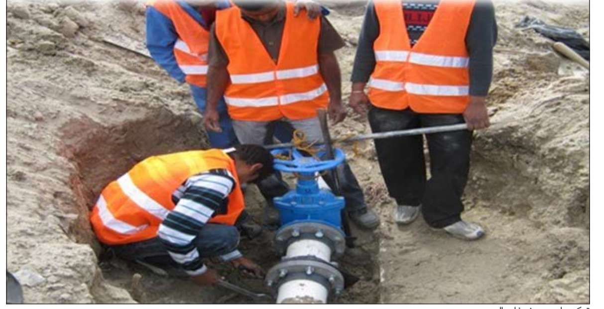
تركيب إحدى مضخات الري
