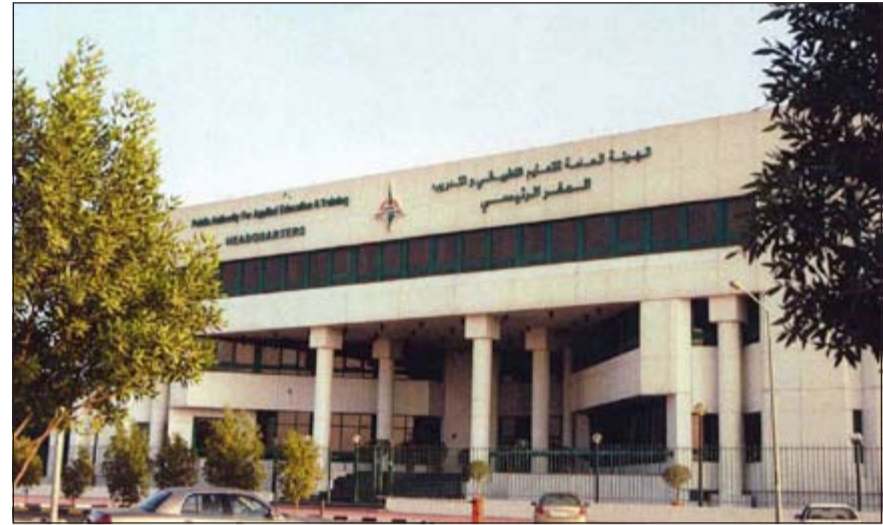
مبنى الهيئة العامة للتعليم التطبيقي
