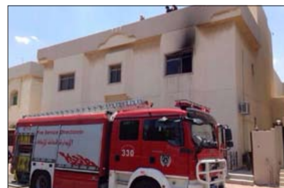
عربة إطفاء أمام المنزل وتبدو آثار الحريق على شبكات الطابق الأول
