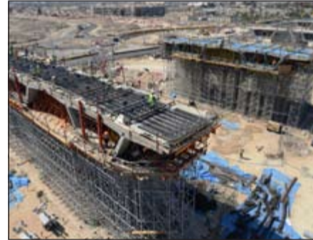
جانب من أعمال المشروع
