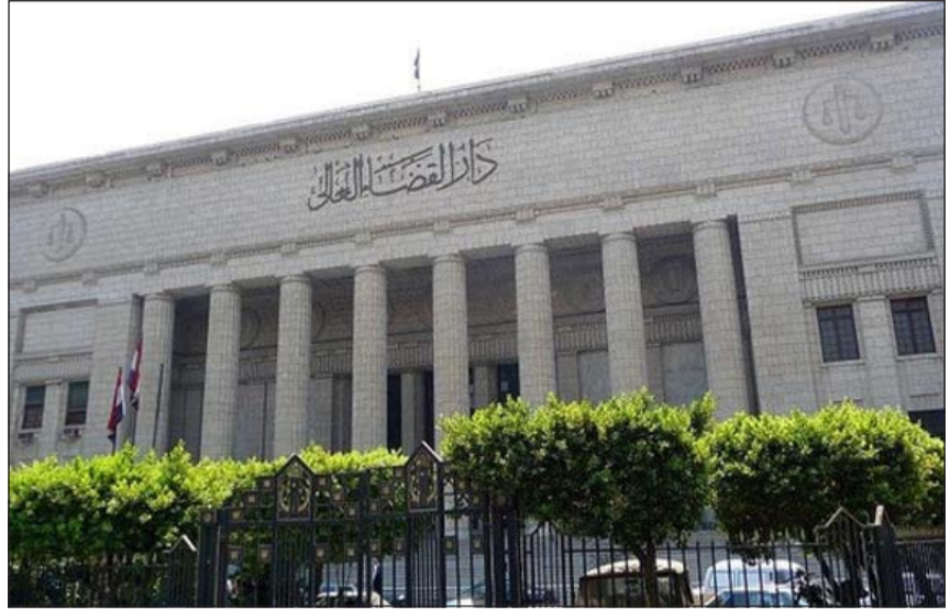
مبنى دار القضاء العالي في القاهرة
