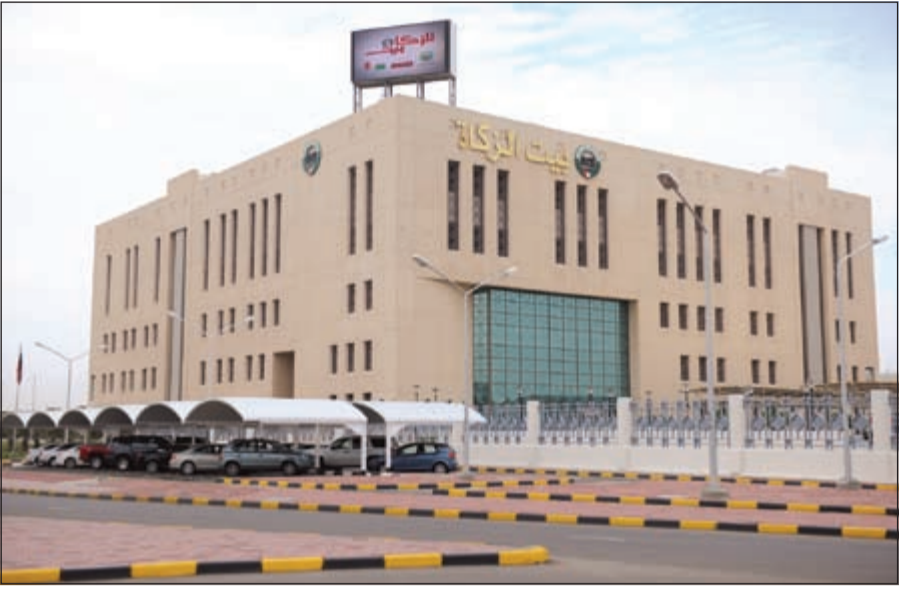
مبنى بيت الزكاة
