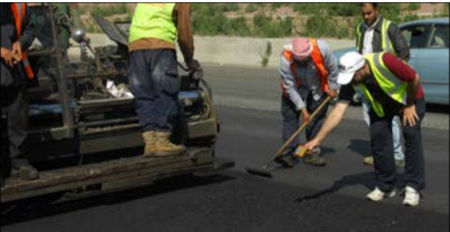
قياس مواصفات الأسفلت ودرجة الحرارة
