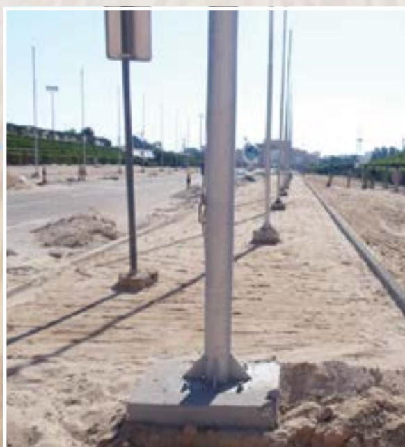
أعمال الطرق والأرصفة بجميع مواقع الجامعة
