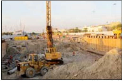
الأعمال الإنشائية في النفق
