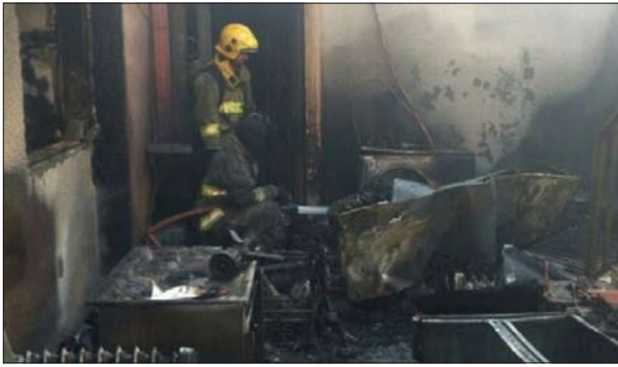
آثار الحريق من الداخل
