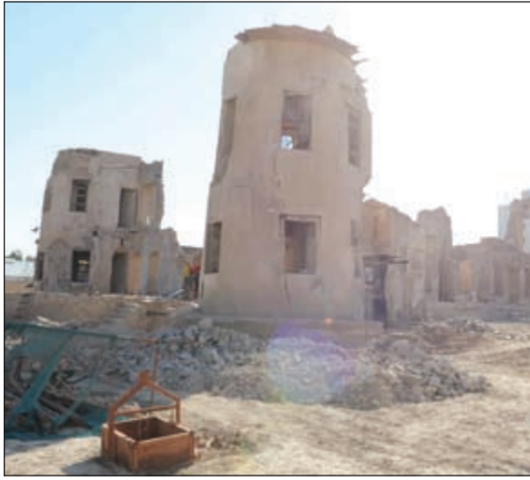
المبنى بعد إخلائه إثر الحادث
