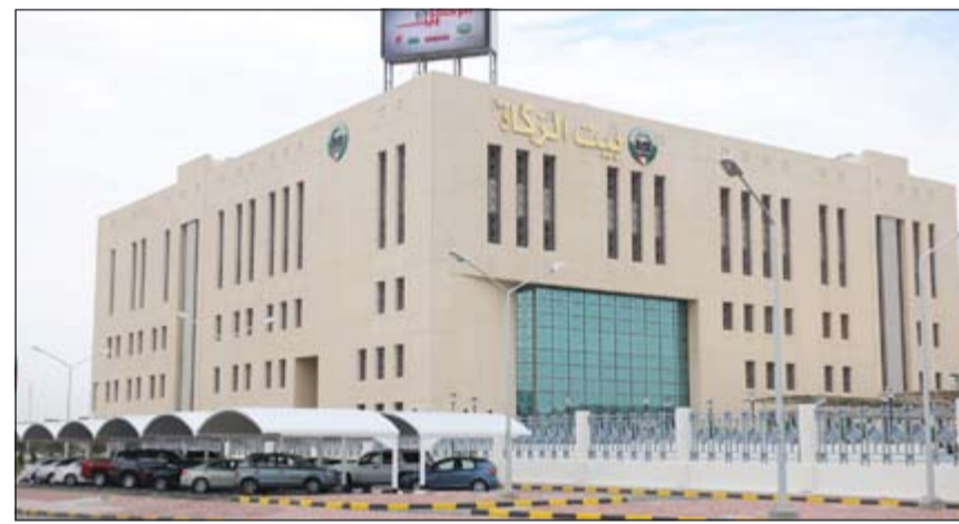
مبنى بيت الزكاة
