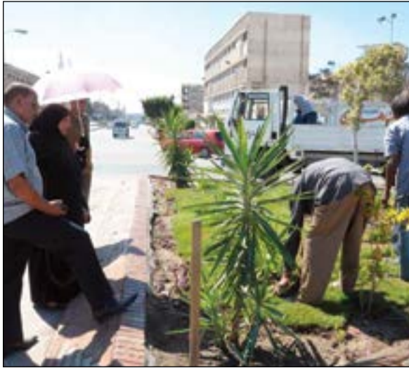
أعمال تهيئة الميدان تجري على قدم وساق
