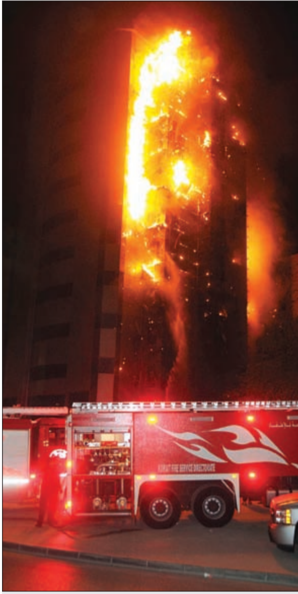
واجهة المبنى كانت سبب الحريق
