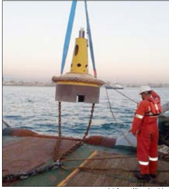
إجراءات تثبيت الأنبوب النفطي
