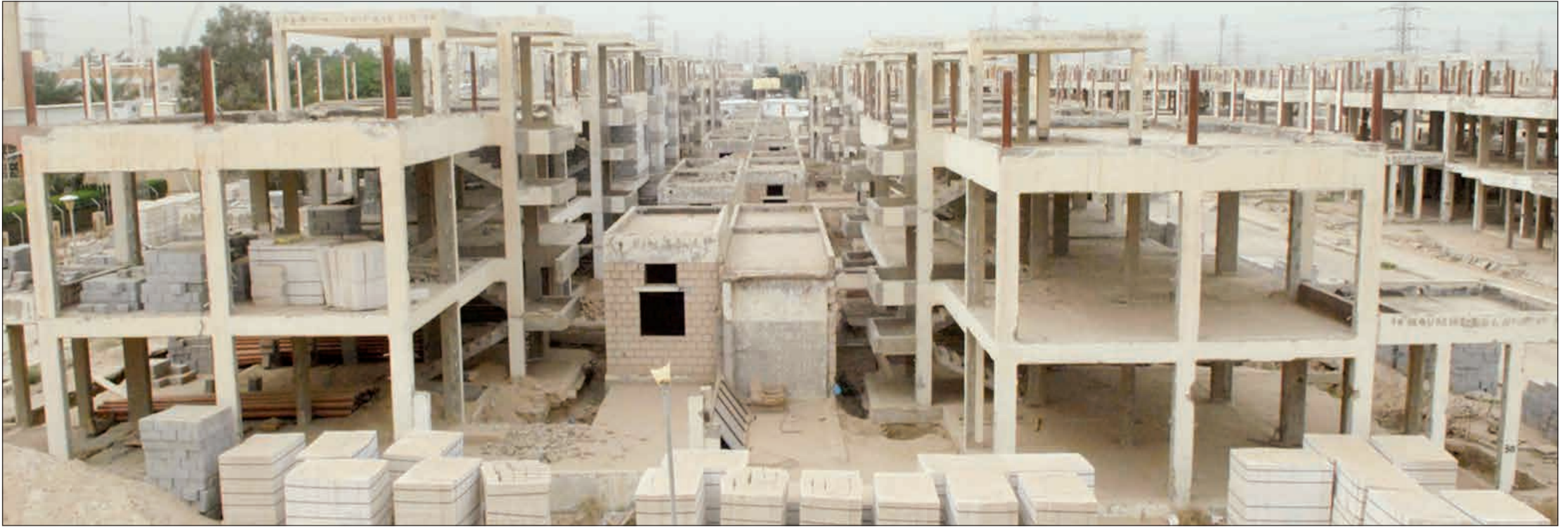
جانب من البناء والإنشاء في منازل وبيوت منطقة الظهر
