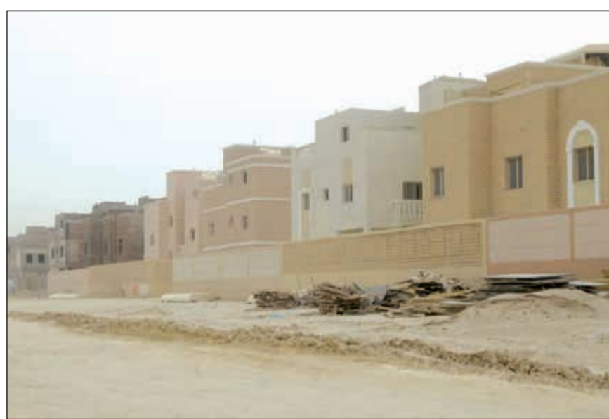
اعمال البناء والإنشاء في مدينة صباح الاحمد السكنية
