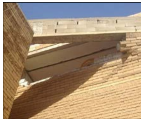
التقرب الذي أحدثه الانفجار في جدار الطابق الثالث
