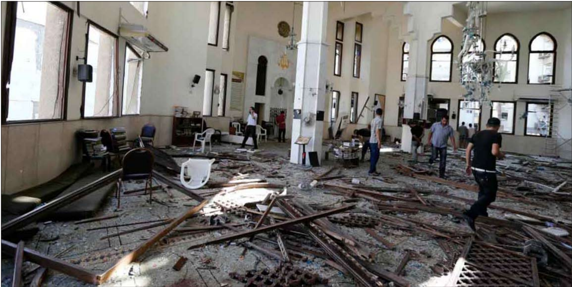
الأضرار التي لحقت بمسجد النجوى
