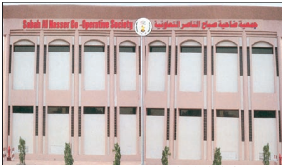
المبنى الجديد لجمعية صباح الناصر التعاونية
