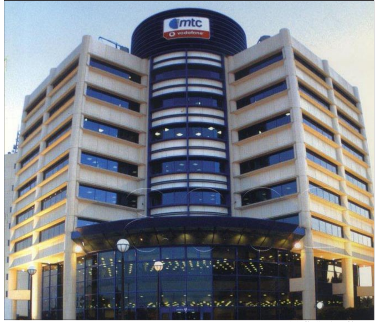
مبنى شركة الاتصالات المتنقلة سابقا
