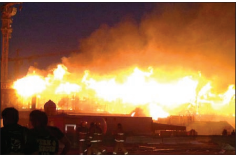
النيران وقد تلاججت في مبنى كلية الهندسة
