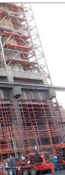
سقالات في وحدة الفحم في مصفاة ميناء عبدالله أثناء عملية الصيانة
