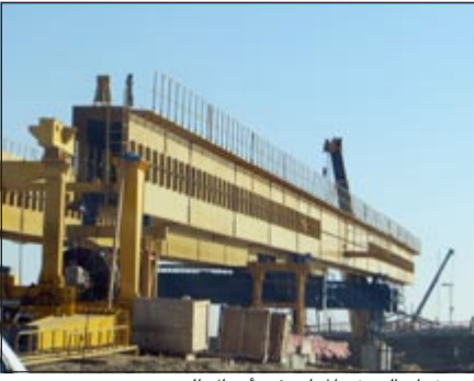
استخدام الونش المعلق في أعمال الجسر
