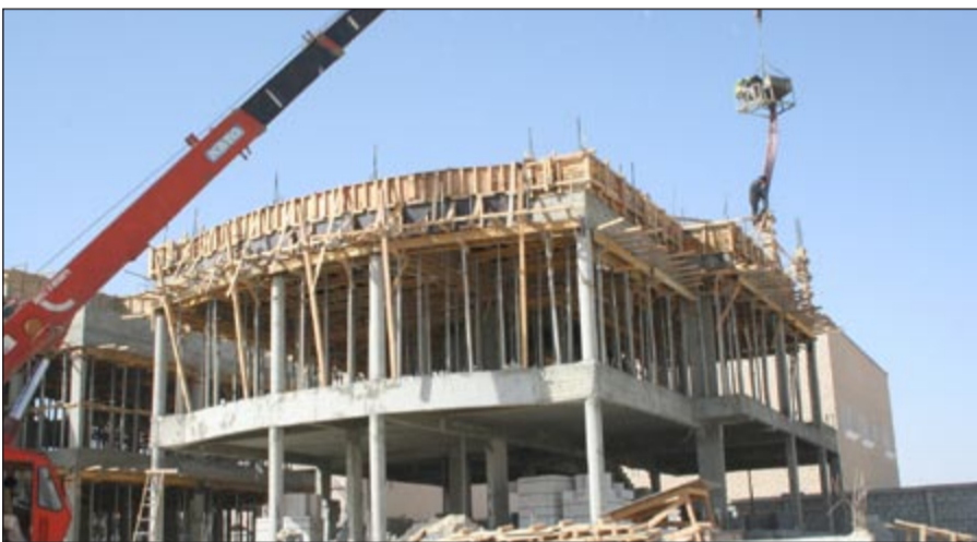
أعمال البناء على قدم وساق
