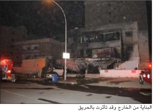
البناية من الخارج وقد تأثرت بالحريق
