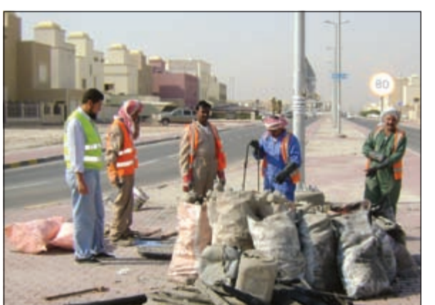
تنظيف خطوط الصرف الصحي من المخلفات
