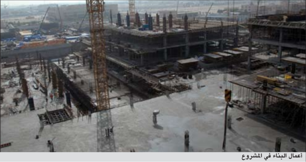
أعمال البناء في المشروع
