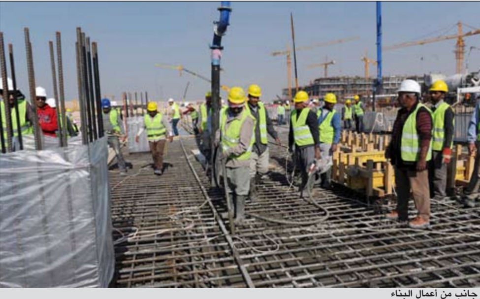
جانب من أعمال البناء
