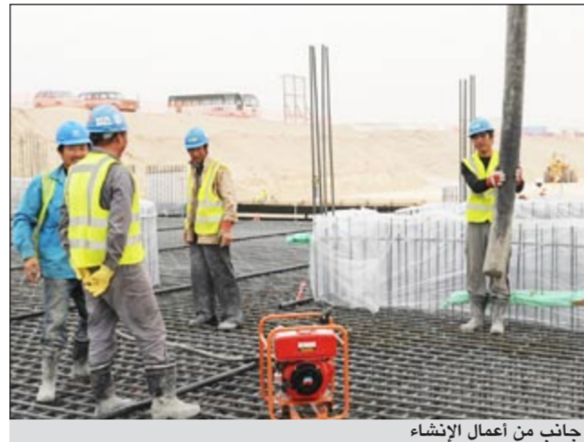
جانب من أعمال الإنشاء
