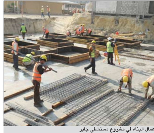
أعمال البناء في مشروع مستشفى جابر
