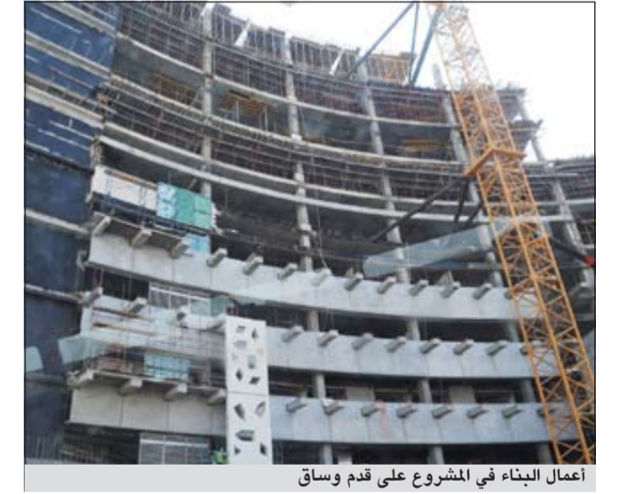
أعمال البناء في المشروع على قدم وساق
