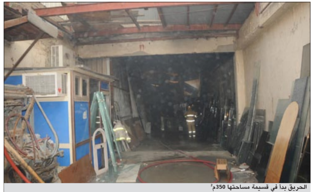
الحريق بدأ في قسيمة مساحتها 350م 2
