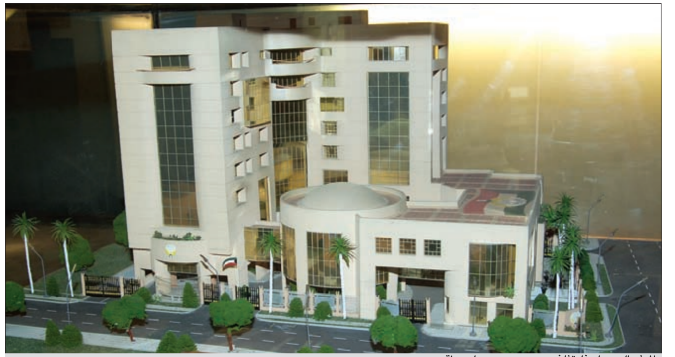
المبنى الجديد لسفارتنا في مصر.. صرح معماري راق
