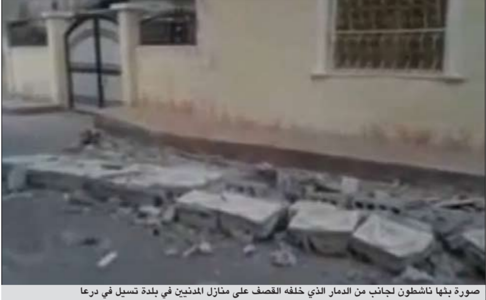
صورة بثها ناشطون جانب من الدمار الذي خلفه القصف على منازل المدنيين في بلدة تسيل في درعا
