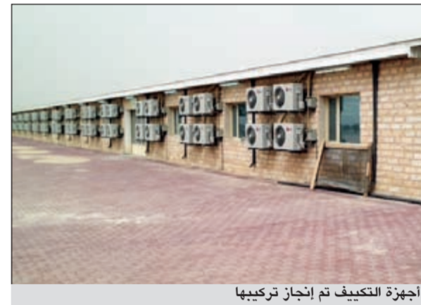
أجهزة التكييف تم إنجاز تركيبها
