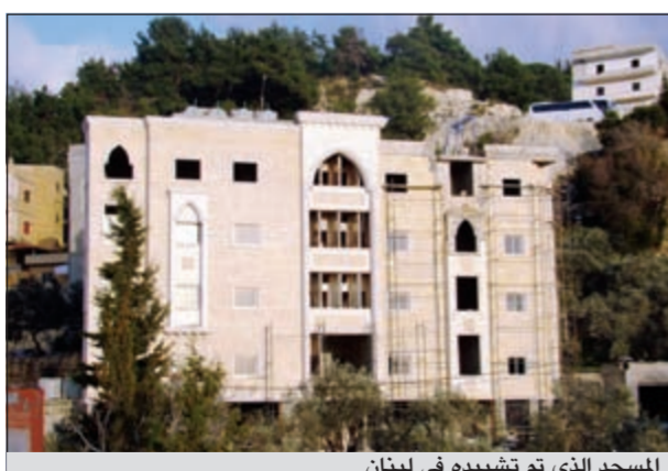
المسجد الذي تم تشييده في لبنان
