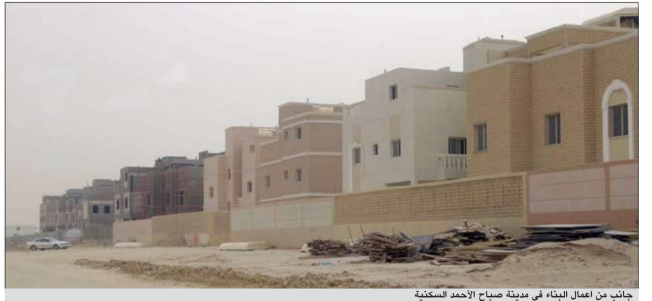
جانب من أعمال البناء في مدينة صباح الأحمد السكنية
