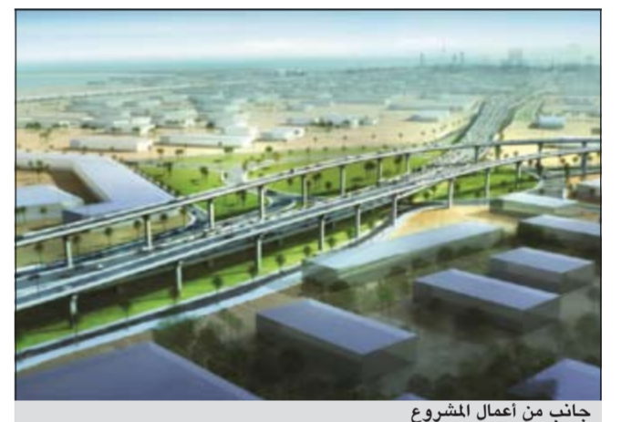
جانب من أعمال المشروع
