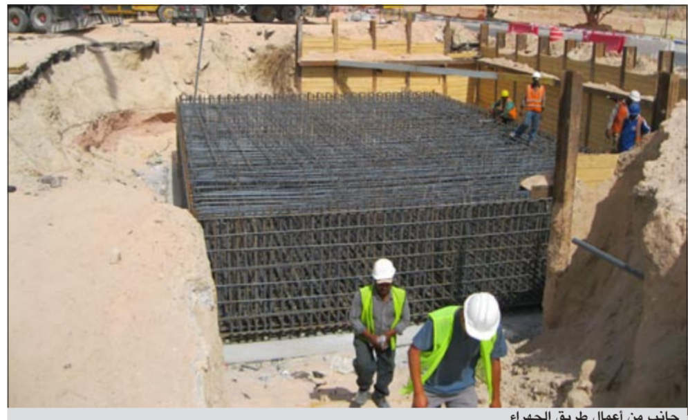
جانب من أعمال طريق الجهراء
