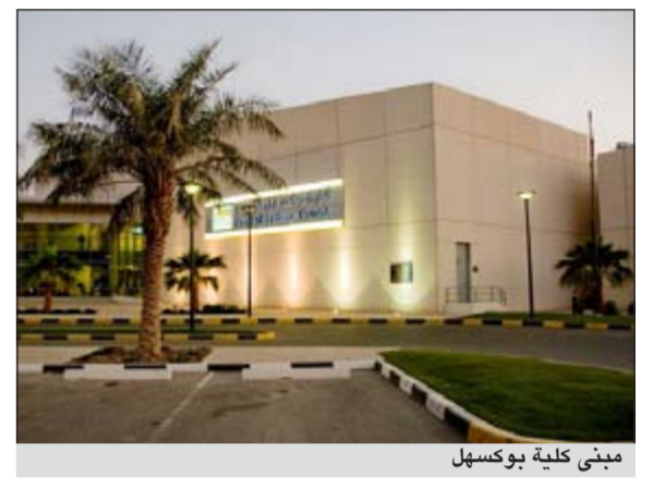
مبنى كلية بوكسهل
