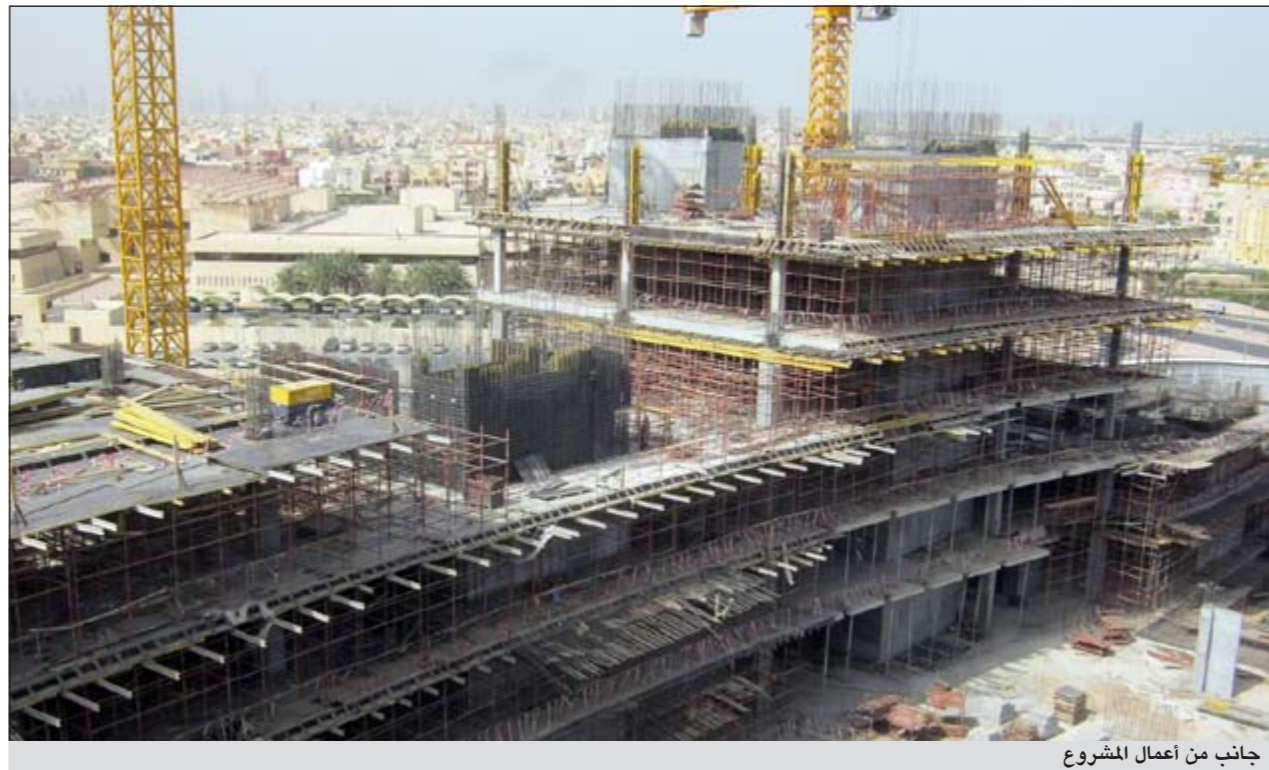
جانب من أعمال المشروع
