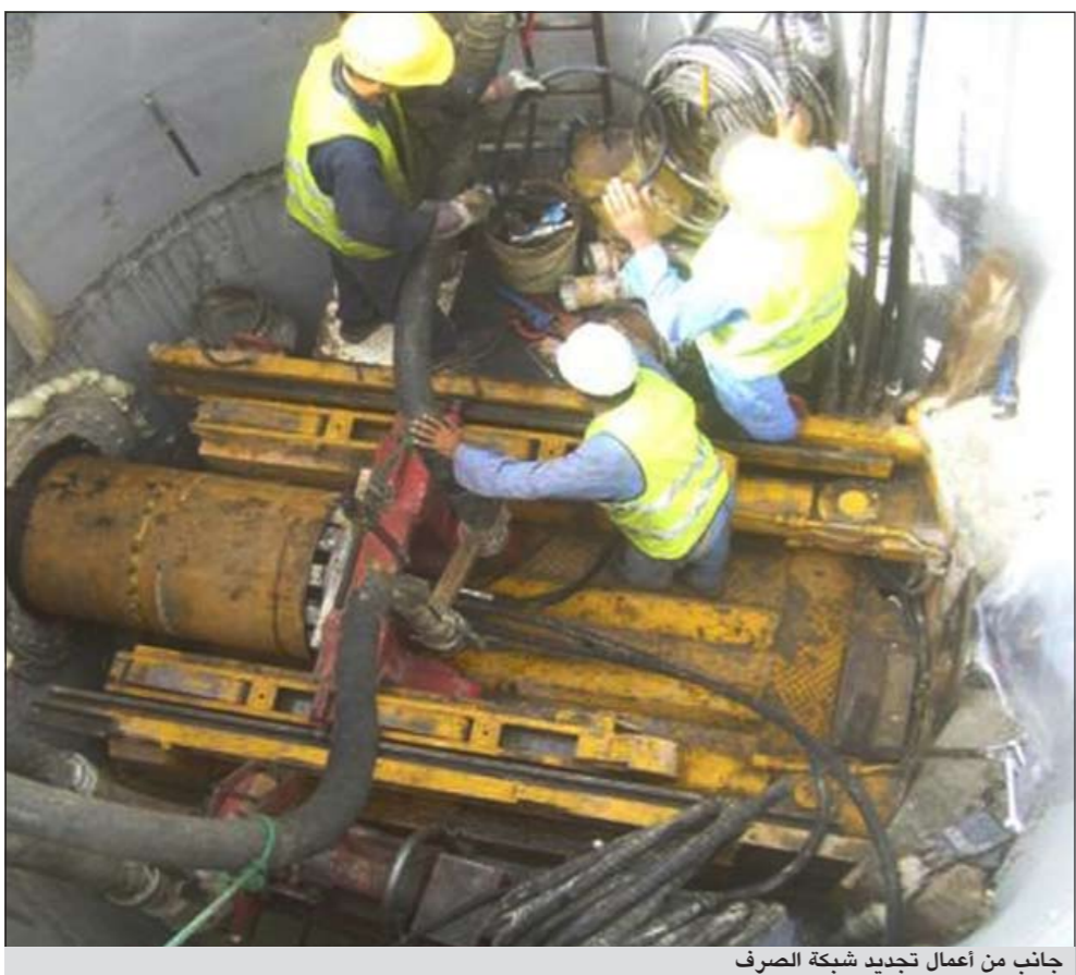
جانب من أعمال تجديد شبكة الصرف
