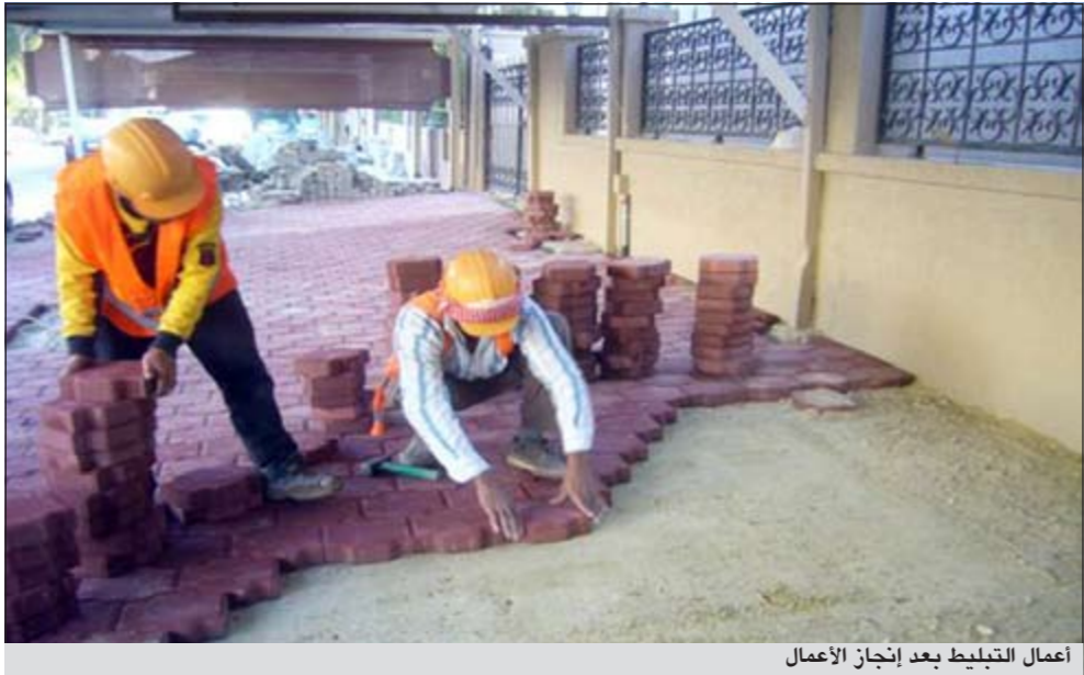
أعمال التبليط بعد إنجاز الأعمال
