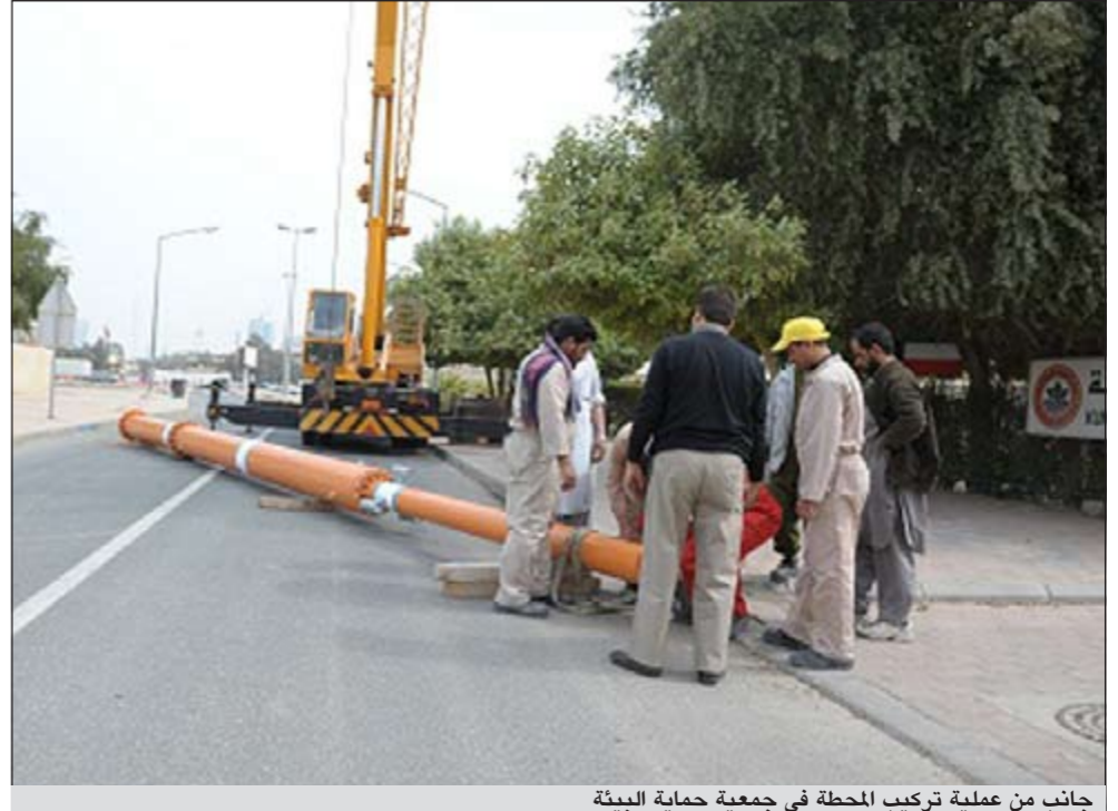
جانب من عملية تركيب المحطة في جمعية حماية البيئة
