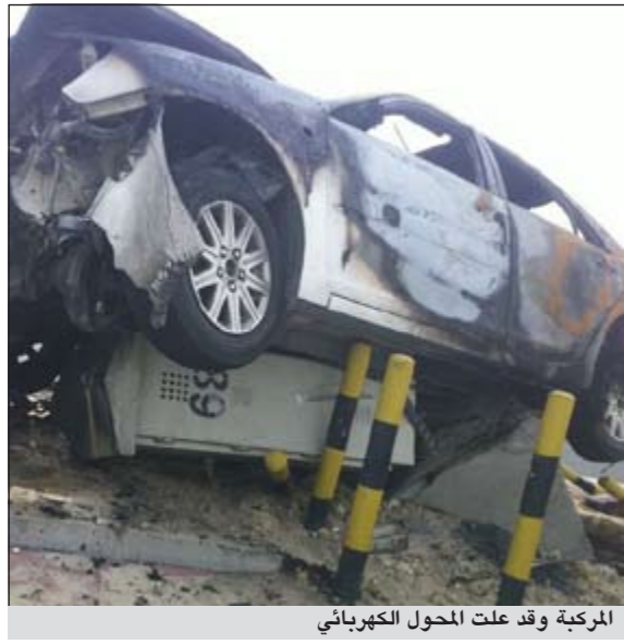
المركبة وقد علت المحول الكهربائي
