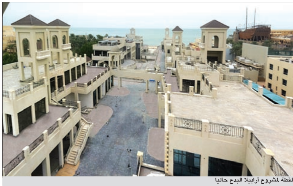
لقطة لمشروع أرابيلا البدع حالياً
