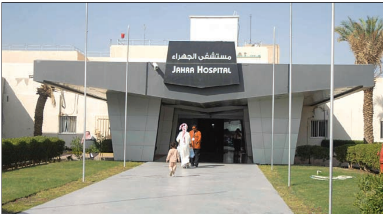
مدخل مبنى مستشفى الجهراء
